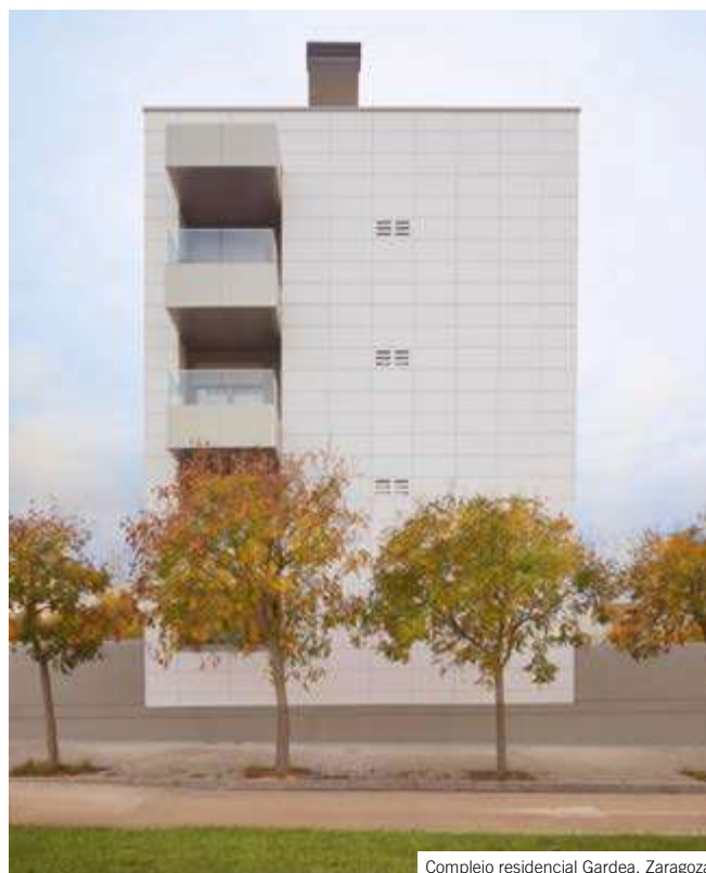
Complejo residencial Gardea, Zaragoza
