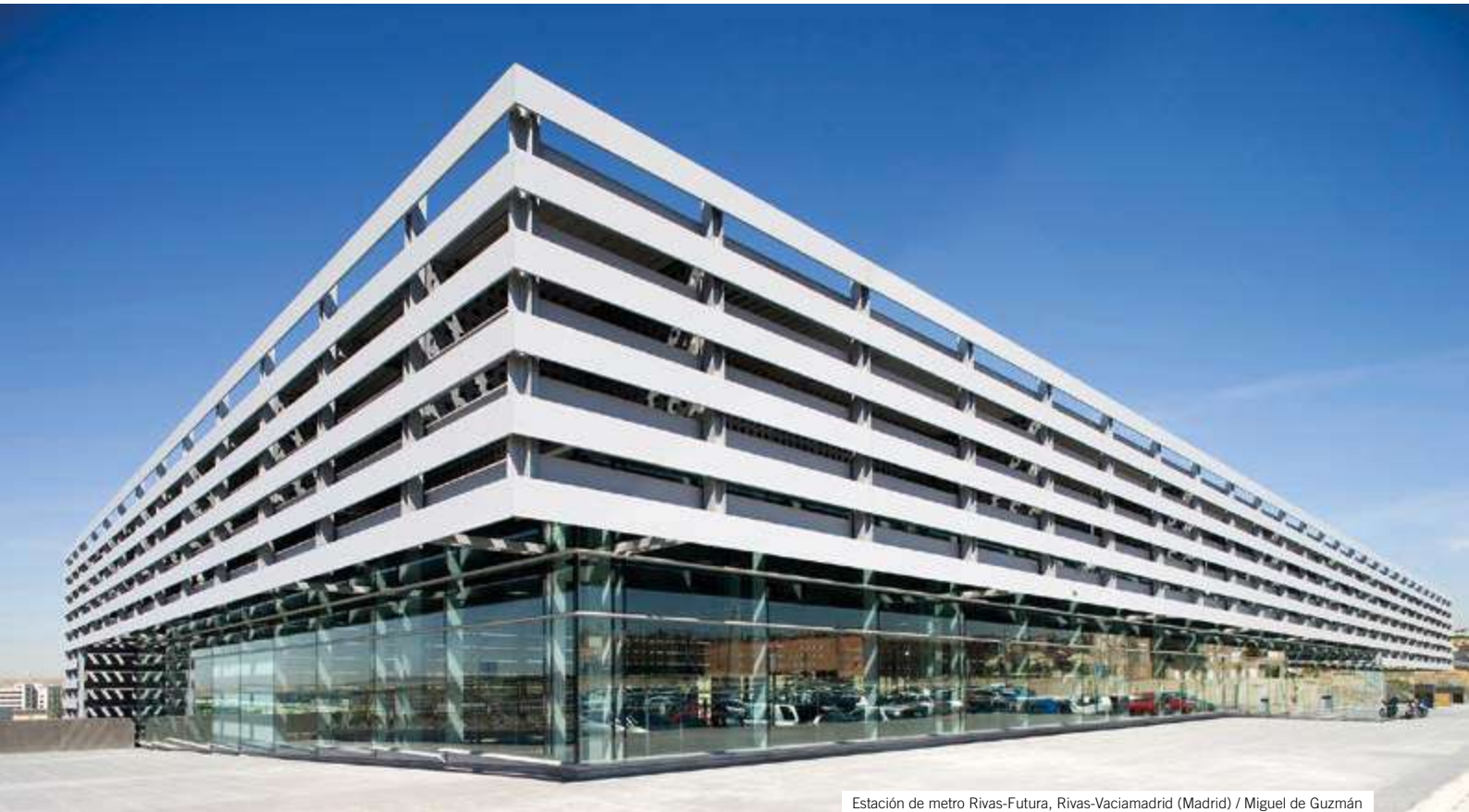
Estación de metro Rivas-Futura, Rivas-Vaciamadrid (Madrid) / Miguel de Guzmán
