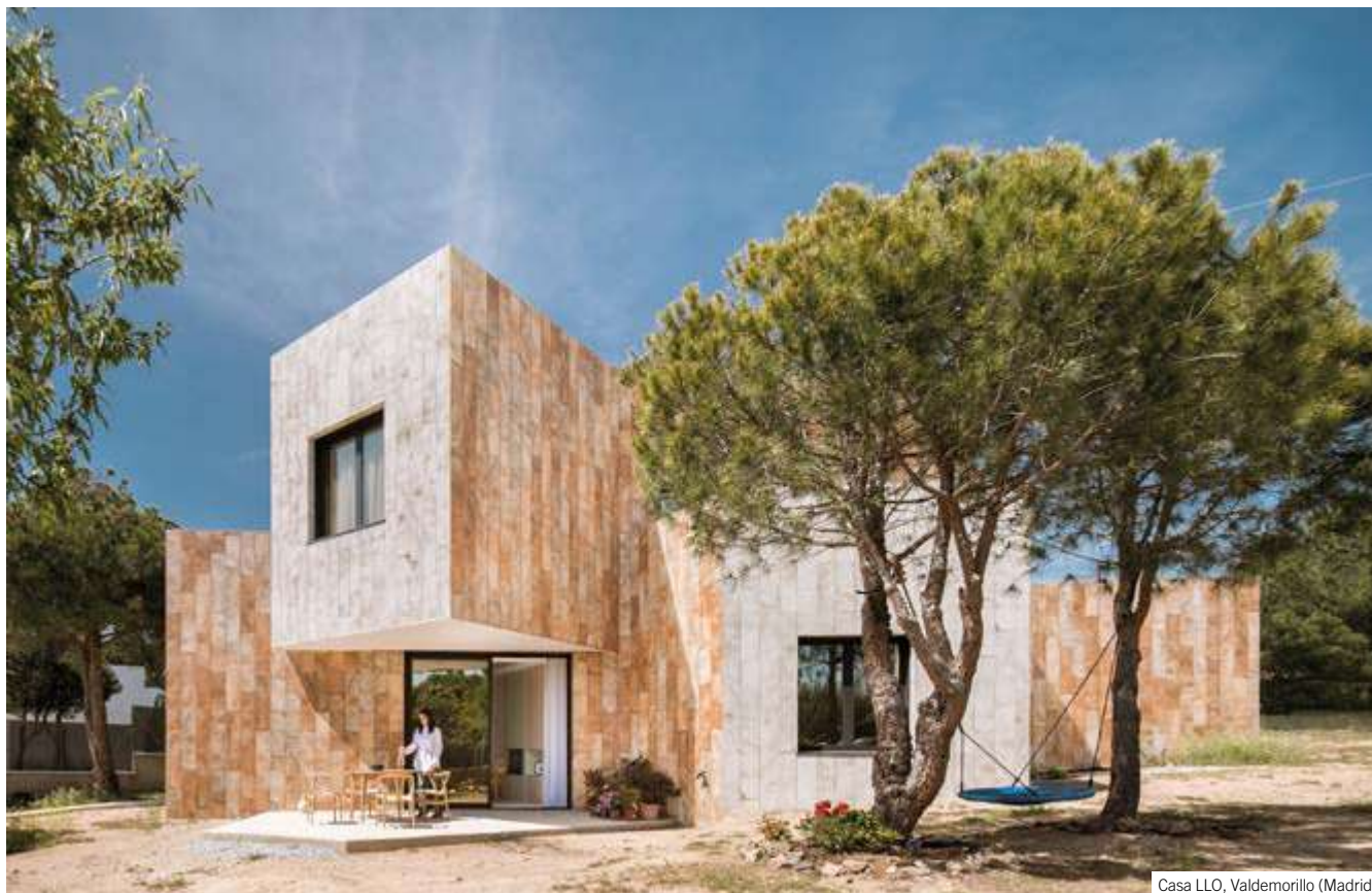
Casa LLO, Valdemorillo (Madrid)
