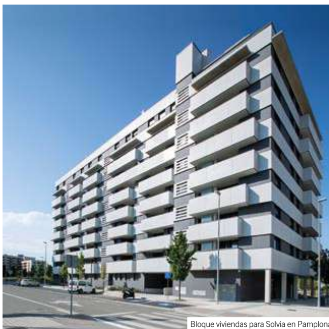
Bloque viviendas para Solvia en Pamplona
