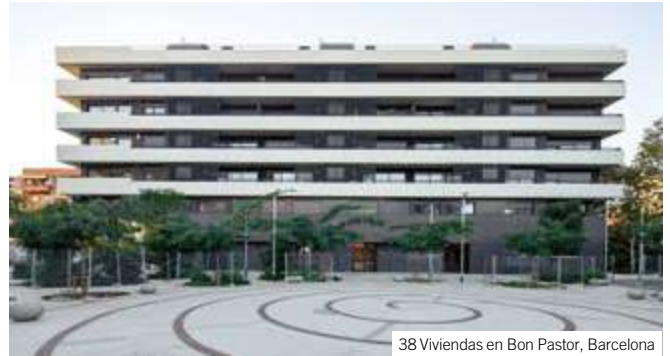
38 Viviendas en Bon Pastor, Barcelona
