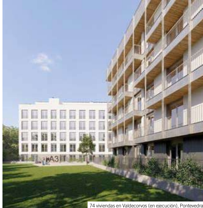
74 viviendas en Valdecorvos (en ejecución), Pontevedra
