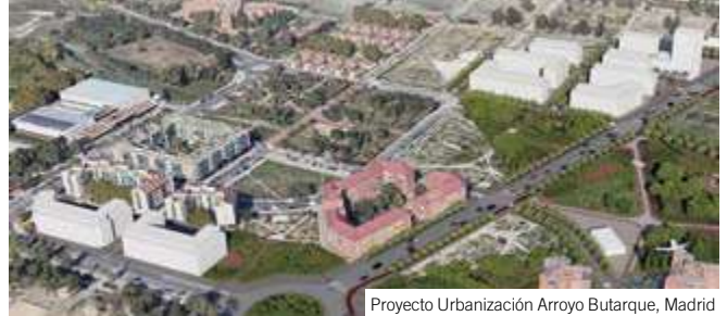
Proyecto Urbanización Arroyo Butarque, Madrid
