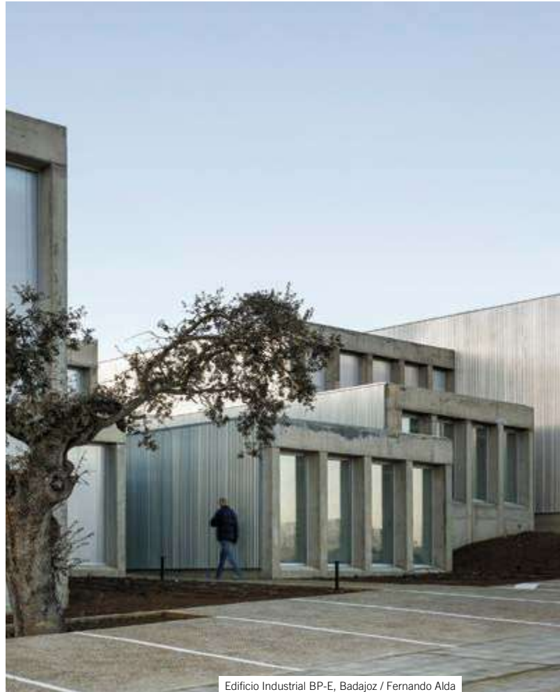
Edificio Industrial BP-E, Badajoz / Fernando Alda
