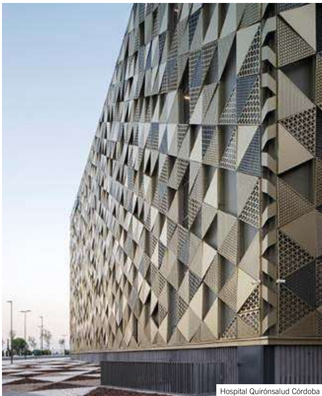
Hospital Quirónsalud Córdoba
