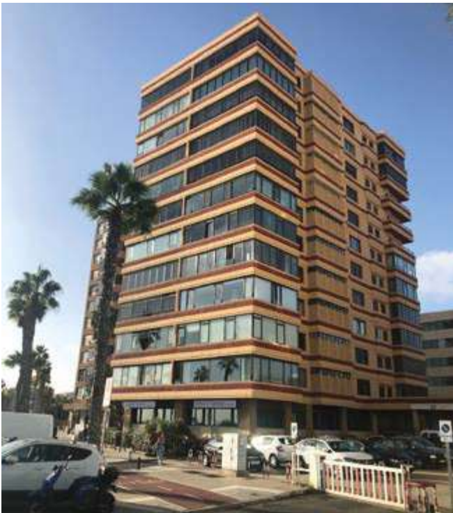
Rehabilitación fachadas Edificio Atlántico (Obra finalizada).
