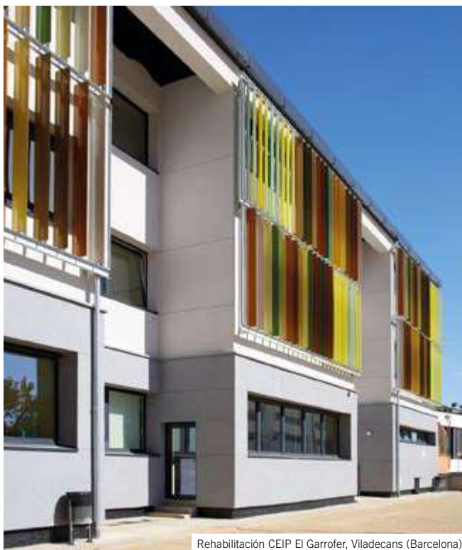
Rehabilitación CEIP El Garrofer, Viladecans (Barcelona)
