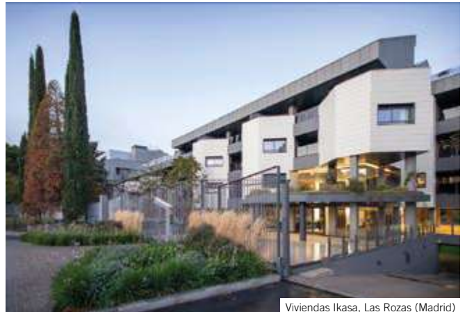
Viviendas Ikasa, Las Rozas (Madrid)
