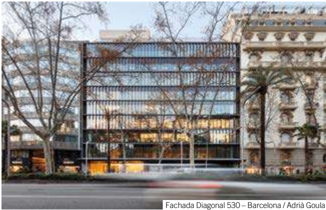
Fachada Diagonal 530 – Barcelona / Adrià Goula
