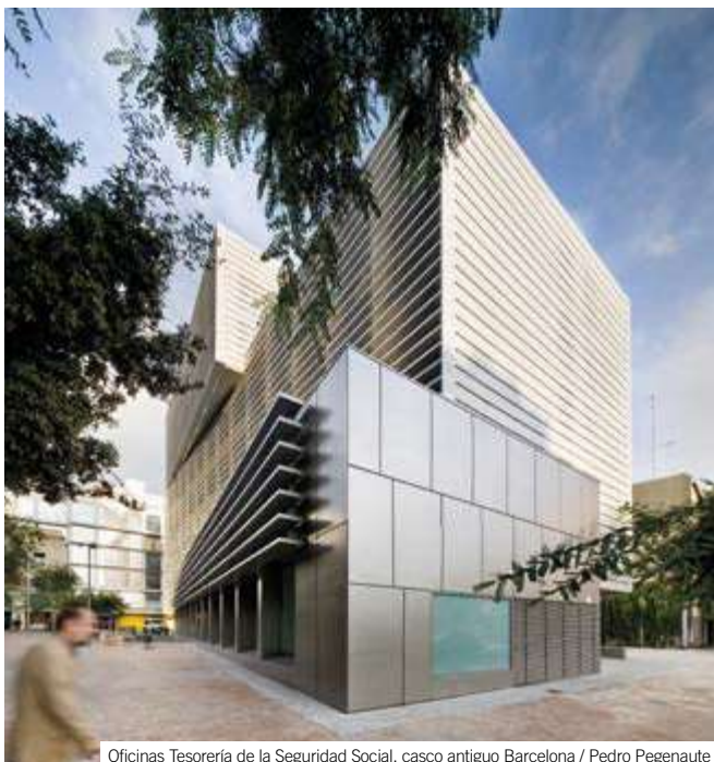
Oficinas Tesorería de la Seguridad Social, casco antiguo Barcelona / Pedro Pegenaute
