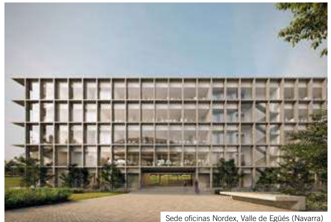
Sede oficinas Nordex, Valle de Egüés (Navarra)
