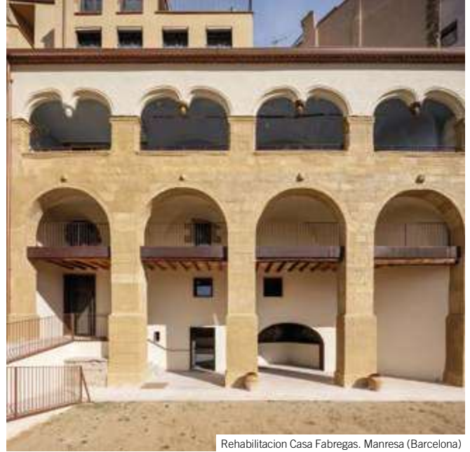
Rehabilitación Casa Fabregas. Manresa (Barcelona)
