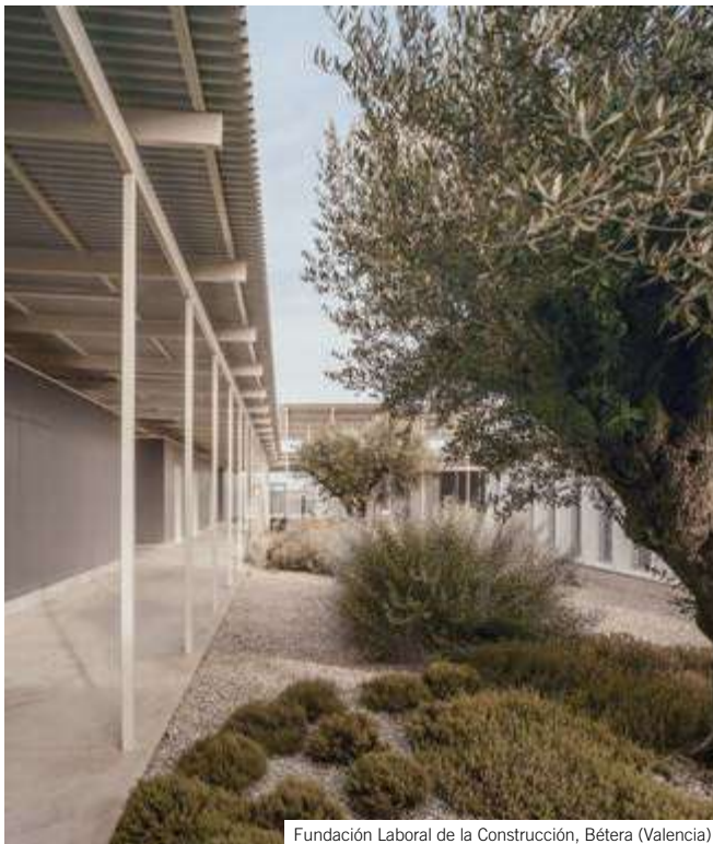
Fundación Laboral de la Construcción, Bétera (Valencia)
