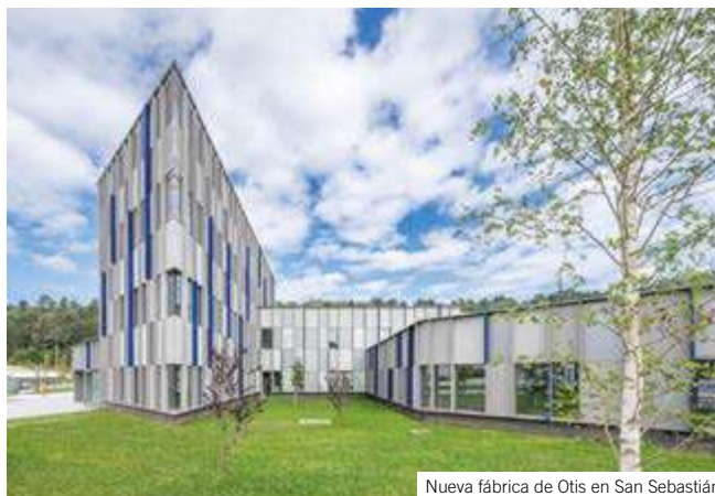
Nueva fábrica de Otis en San Sebastián
