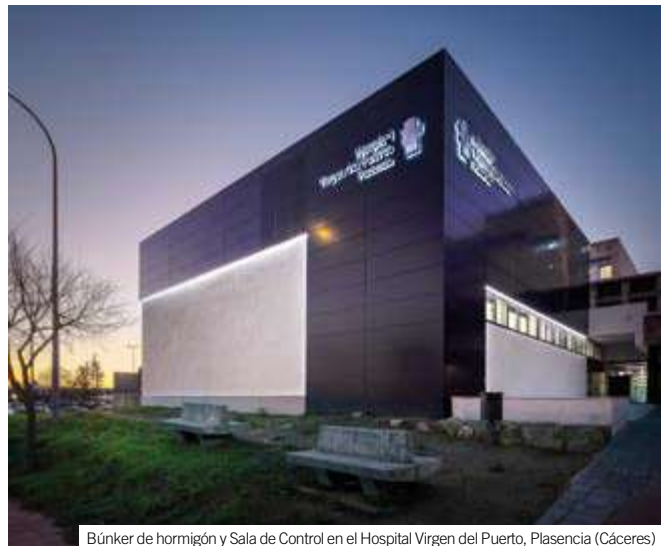
Búnker de hormigón y Sala de Control en el Hospital Virgen del Puerto, Plasencia (Cáceres)
