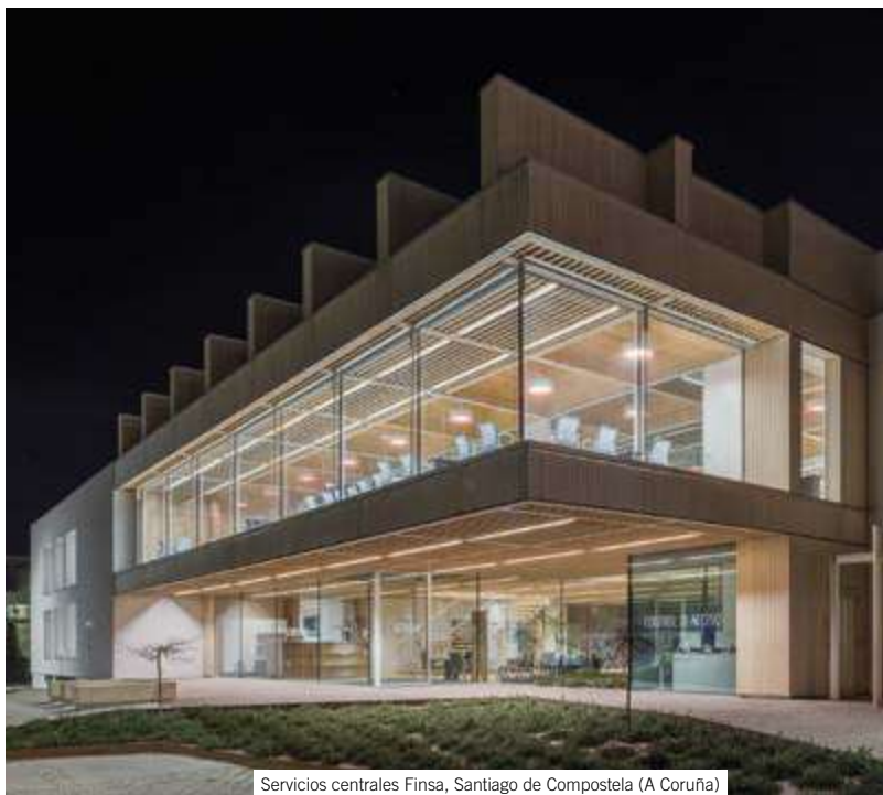
Servicios centrales Finsa, Santiago de Compostela (A Coruña)
