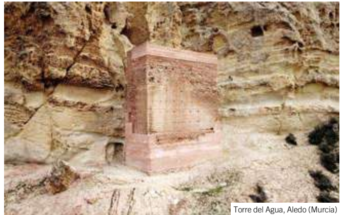
Torre del Agua, Aledo (Murcia)
