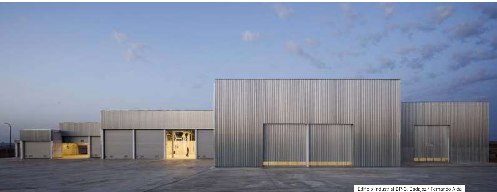
Edificio Industrial BP-C, Badajoz / Fernando Alda
