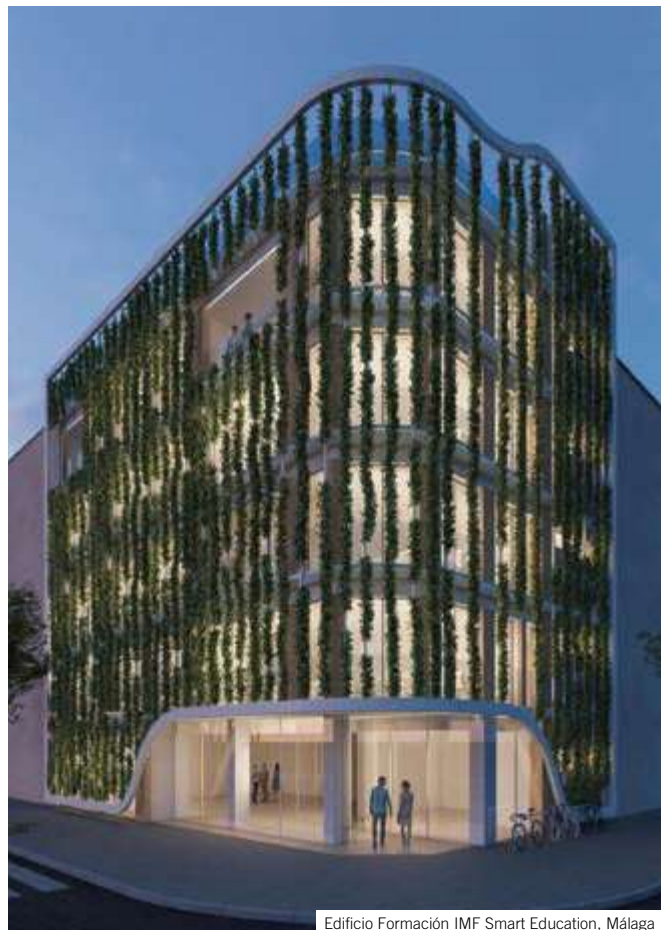
Edificio Formación IMF Smart Education, Málaga
