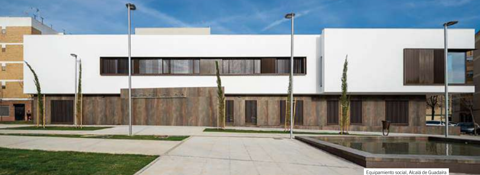
Equipamiento social, Alcalá de Guadaíra
